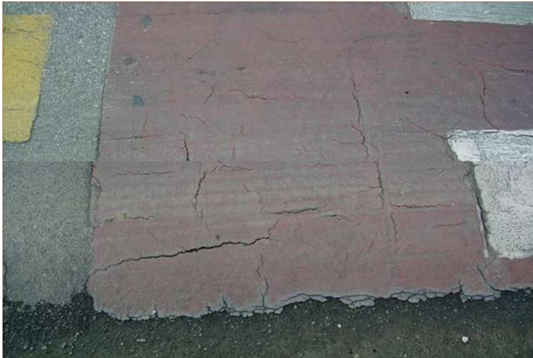
Этот пешеходный переход был сделан двухкомпонентным покрытием, которое может быть и прочным, но сжимает и разрушает асфальт. Ремонту не подлежит, требуется замена.
